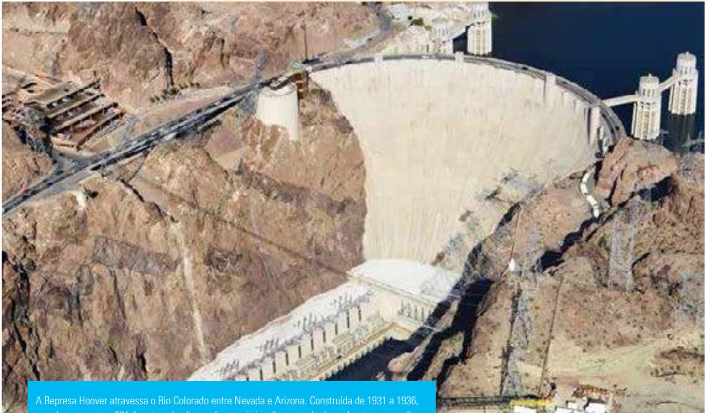
A Represa Hoover atravessa o Rio Colorado entre Nevada e Arizona. Construída de 1931 a 1936, essa barragem tem 221,4 metros de altura e fornece irrigação, controle de enchentes e geração de energia hidrelétrica. Na Seção 8.3 você aprenderá a estabelecer e resolver uma integral para calcular a força sobre a barragem exercida pela pressão da água.
